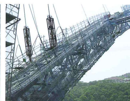
メタルアーチ橋への昇降設備(工事進捗により角度が変わる)
