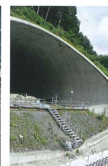
トンネル入口への昇降設備
