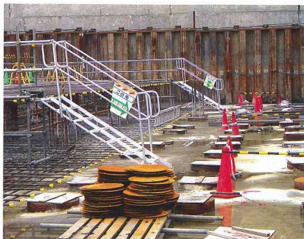
地足場より作業場への昇降設備
