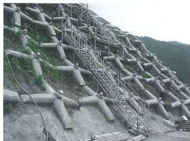
作業員の昇降用通路
