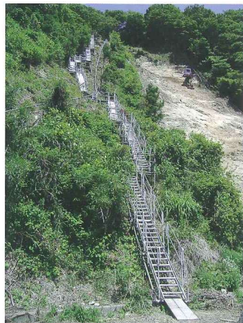
法面工事準備段階で使用
