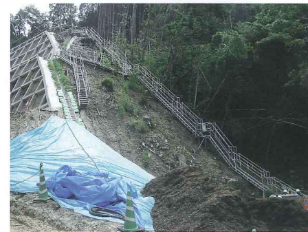
砂防流路工事（昇降及び作業足場）
