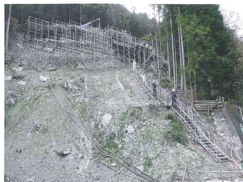
作業員の昇降用通路
