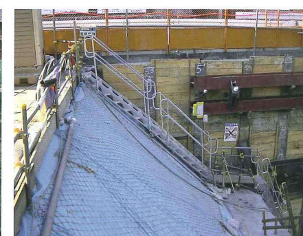
橋梁基礎部への昇降設備
