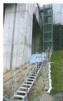
上部工工事の昇降用通路
