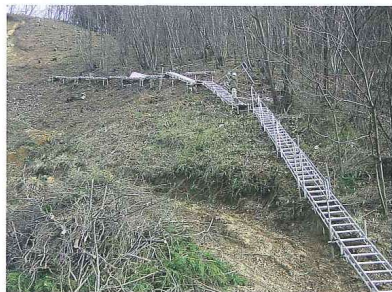
作業員の昇降用通路（組立状況）
