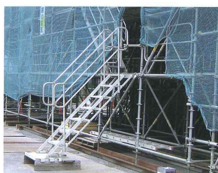
足場支保工への昇降用通路
