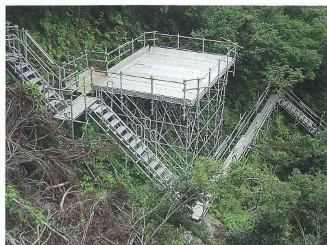
作業員の昇降用通路（踊場設置例）
