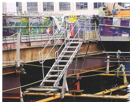
乗入構台より梁上に降る為の昇降設備
