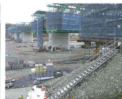
上部工工事の昇降用通路
