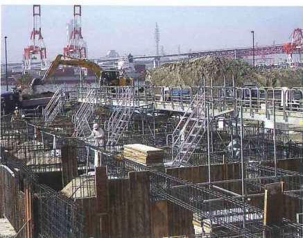
安全通路よりビットへの昇降設備
