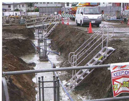
基礎工事の時の昇降設備
