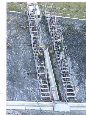
砂防流路工事（昇降及び作業足場）
