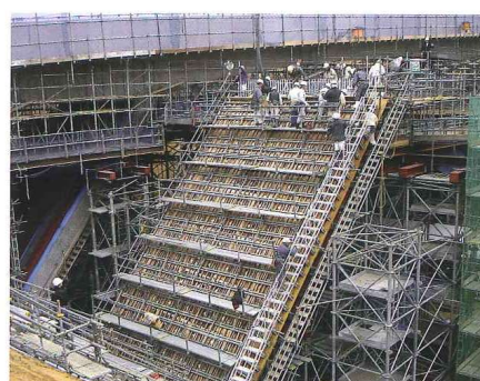
跨道橋架設の昇降設備
