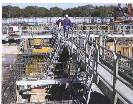
地中梁鉄筋を乗り越える為に使用
