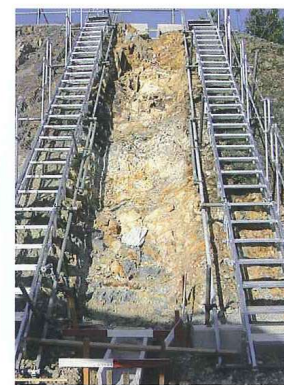
砂防流路工事（昇降及び作業足場）
