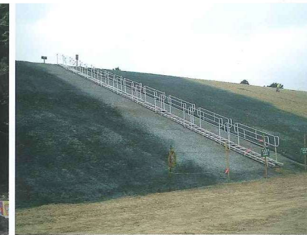
河川護岸工事用の昇降設備
