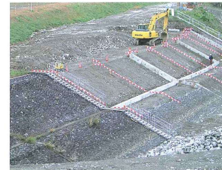
河川護岸工事用の昇降設備
