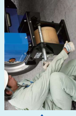
ロックを解除し、固定ピンを穴から抜く
