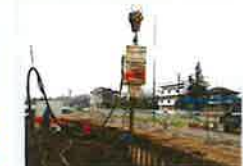
矢板規格: SP-Ⅲ型 (L=10.5m) 発注: 国土交通省 工事名: 大野川河川工事
