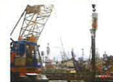
矢板規格: SP-Ⅲ型 (L=16m) 発注: JR東日本 工事名: 横浜駅内新設工事
