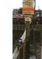
杭規格: H400×400 (L=32m引抜き) 発注: 広島市 工事名: 平和橋(仮橋)架設工事
