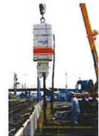
矢板規格: SP-Ⅱ型 (L=6m) 発注: JR九州 工事名: 羽犬塚駅構内自由通路新設他
