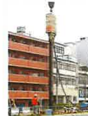
杭規格: H300×300 (L=28.6m) 発注: 広島市 工事名: 明治橋仮歩道橋設置工事
