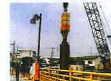
杭規格: φ600×12m 発注: 神奈川県 工事名: 総合治水対策特定河川工事(引地川)
