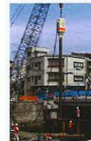
杭規格: H350×350 (L=34m) 発注: 横浜市 工事名: 坂下橋架設工事
