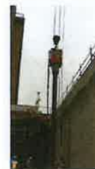
杭規格: H400×400 (L=18m) 発注: JR東日本 工事名: 品川駅ハット山アンダーパス新設
