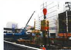
杭規格: H350×350 (L=18m) 発注: 東京都 工事名: 目黒川大崎橋架設工事
