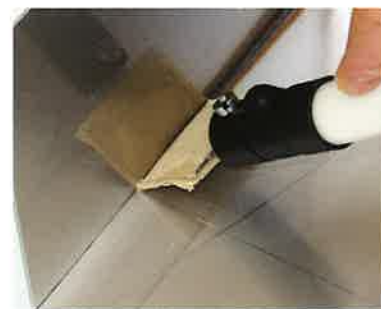
■突き合せ溶接のすきま部
