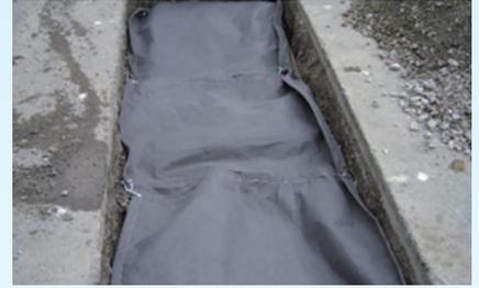
隙間なく水平に充填したニッケンecoモールの上面に仕切り材を設置してください。その際、掘削面とシートの大きさを同サイズにしてください。
