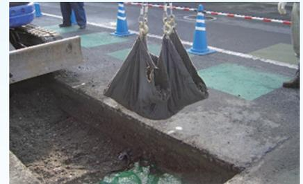
再掘削の際は仕切り材やニッケンecoモールの上面を傷つけないように、碎石をある程度除去してください。残った少量の碎石は専用シートとともに撤去してください。
