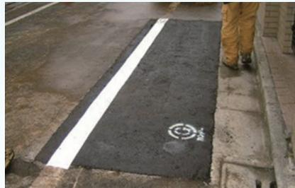
アスコンを打設して作業終了。道路の解放後は、路面の沈下に充分ご注意ください。また、定期的な観察も行ってください。
