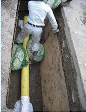
必ず掘削坑の側面にコンパネを設置するようにしてください。また、山留を設置した状態でも施行可能です。(コンパネは路床上面まで)
